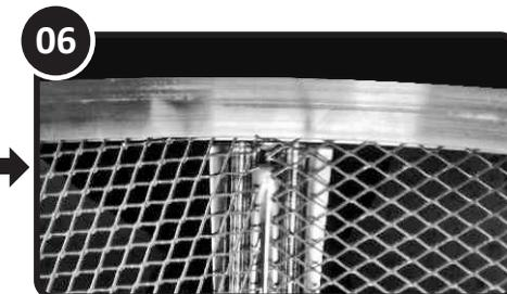
Prenda as telas as longarinas utilizando os grampos "U" conforme a figura 07. Recomendamos que seja utilizado 05 grampos em cada longarina para uma perfeita fixação. Também colocar um grampo no centro da tela em cada fechamento, garantindo assim que a mesma não solte com a ação do vento.
